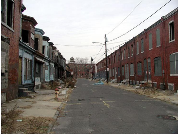
شكل (١٤) المباني القديمة المهجورة في مدينة كامدن، ولاية نيوجيرسي.
